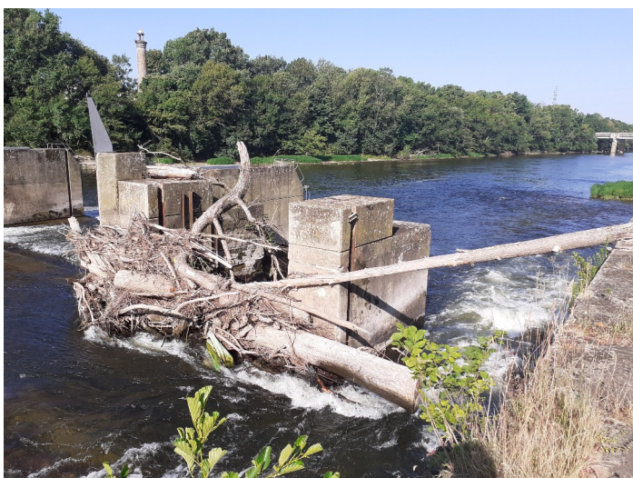
Figure 10: Embâcles accumulés sur la pile des pertuis profonds à retirer
