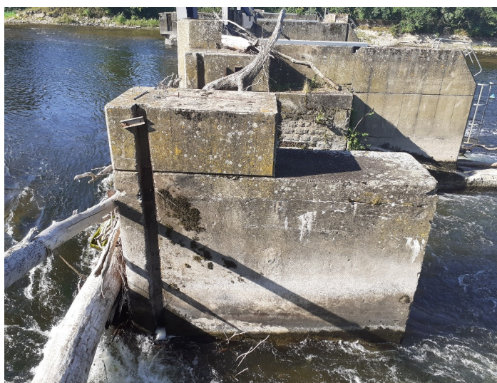
Figure 12: Pile des pertuis profonds à démolir
