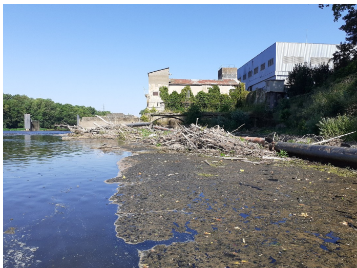
Figure 8: Embâcles accumulés sur la drome à retirer
