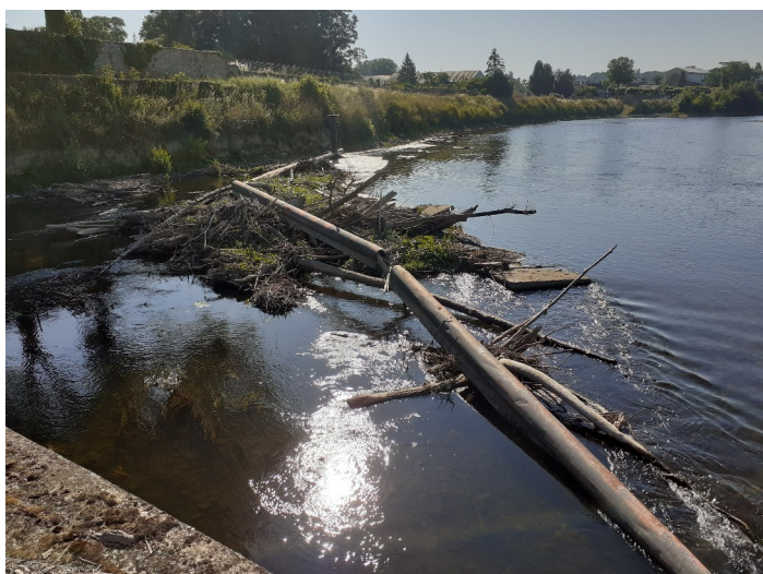
Figure 9: Embâcles accumulés sur la drome à retirer, photo 2
